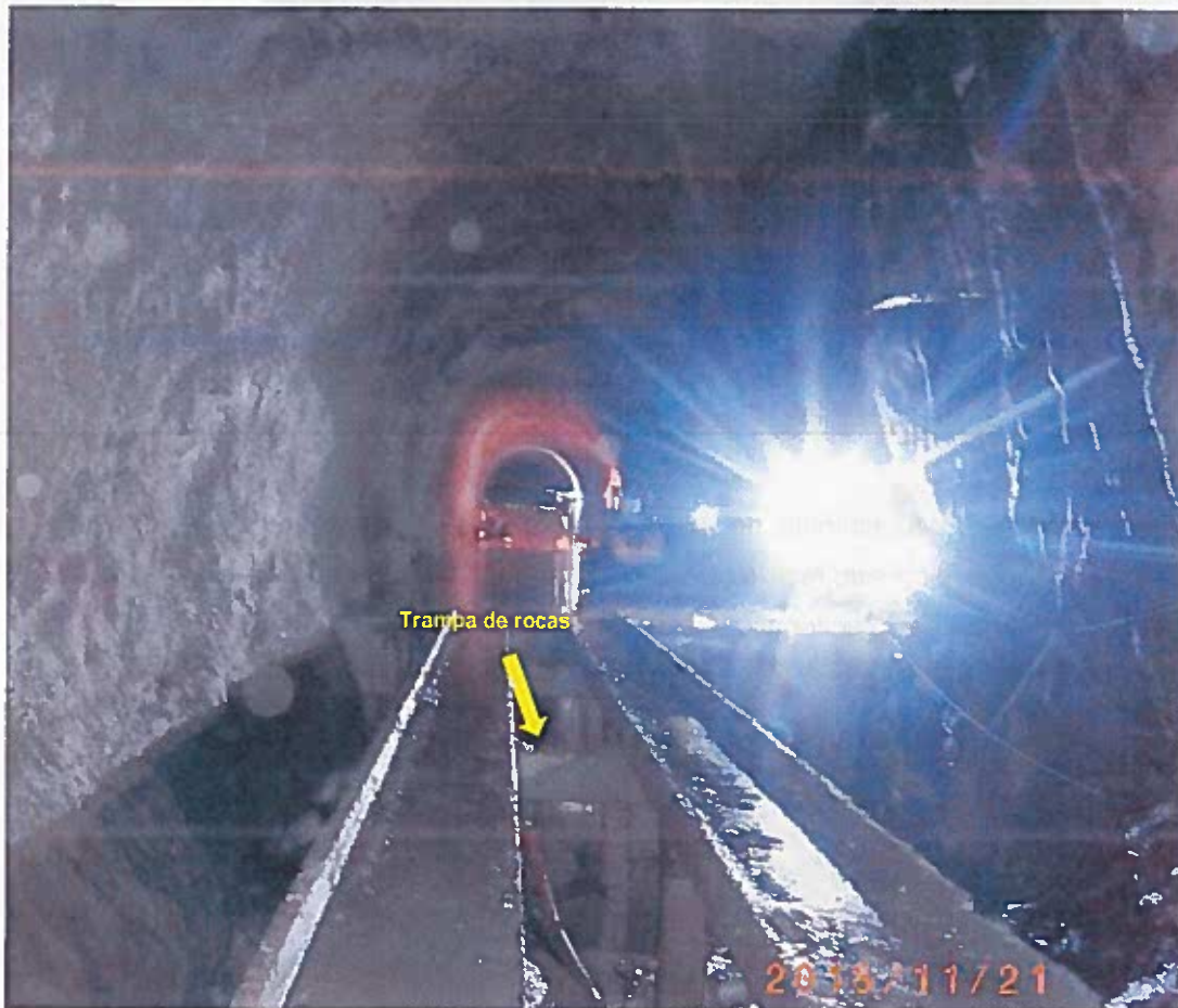
Fotografía 21. Tramo de trampa de rocas en Túnel de Conducción.
