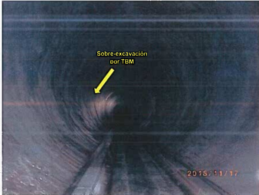
Fotografía 3. Sobre excavación en sección realizada por TBM
