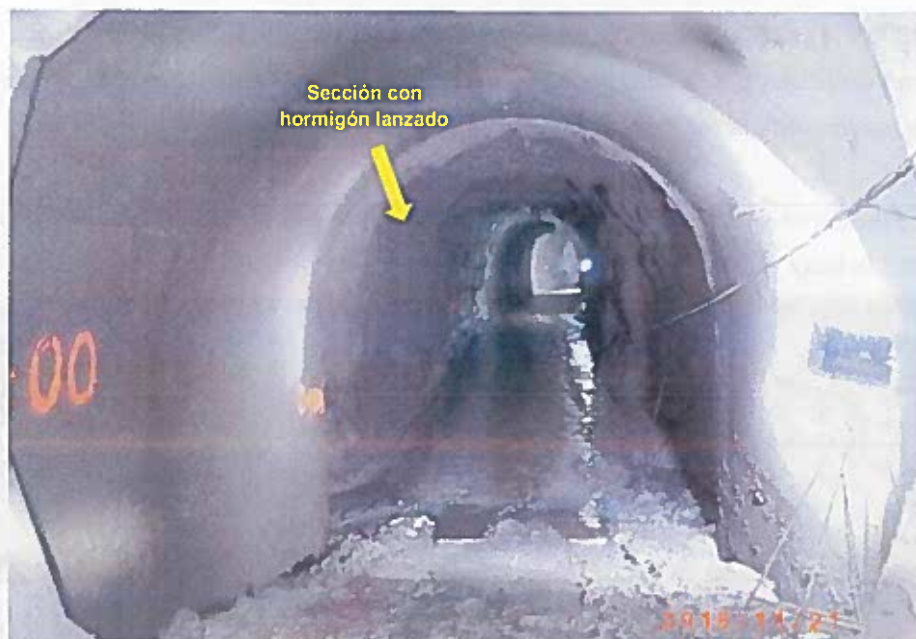
Fotografía 22. Chimenea de Equilibrio con hormigón lanzado en toda la sección.
