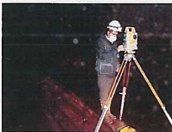
Figura 3.4. Levantamiento subterráneo con estación total
