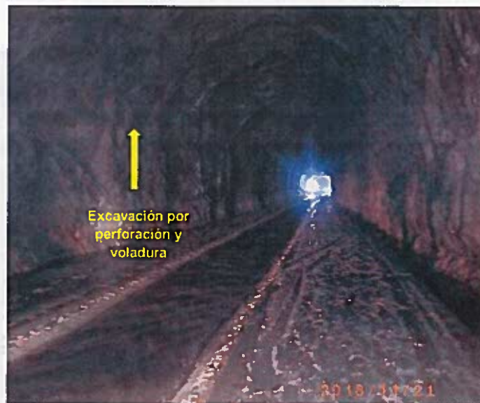
Fotografía 20. Sección del túnel excavada por perforación y voladura.
